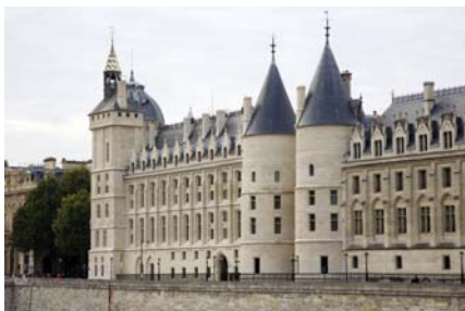
La façade néogothique du quai de l'Horloge
