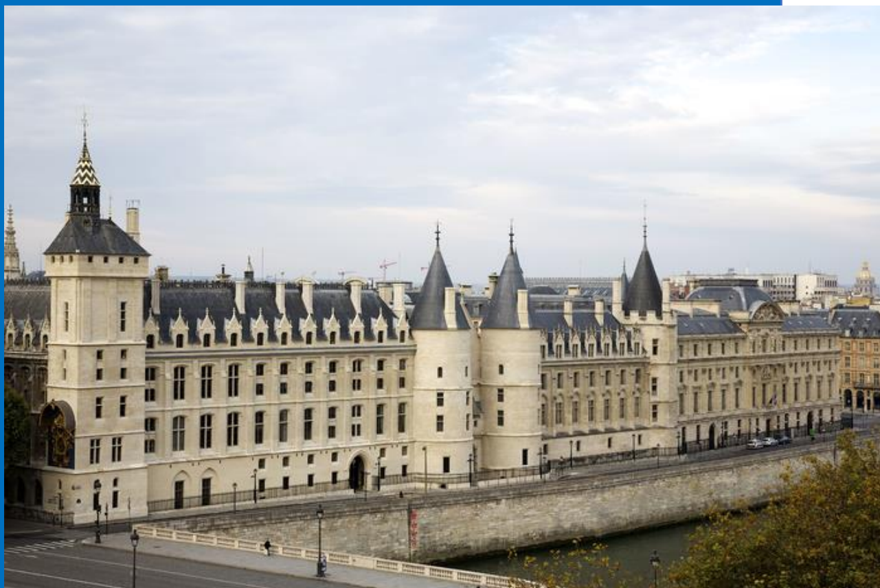
La Conciergerie après la restauration de la tour de l'horloge du palais de la Cité ©Caroline Rose
