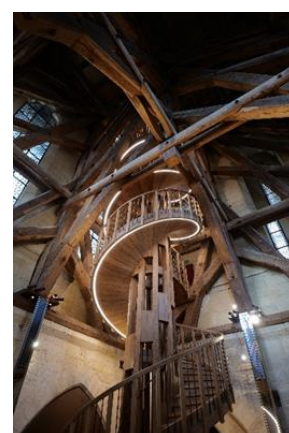
Escalier à double révolution débouchant sur les deux bourdons de la cathédrale. Chef-d'œuvre en bois de chêne massif, il est situé dans la tour sud et permet aux flux montant et descendant de ne pas se croiser. Romaric Toussaint ©
